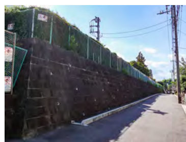
⑫：保存管理等用地 北側擁壁
