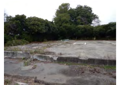
⑤：保存管理等用地内プール跡
