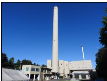
小平・村山・大和衛生組合の外観
