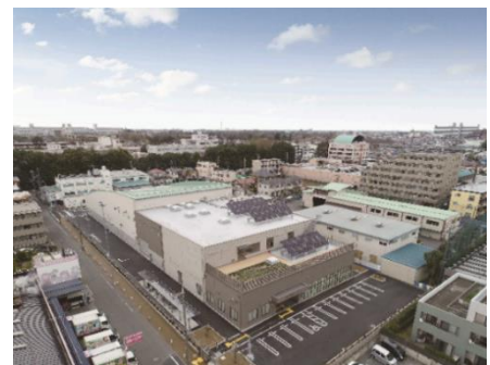
リサイクルセンターの外観
