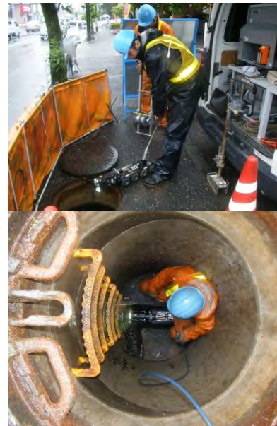
写真 3-7 管きょ内調査の状況
