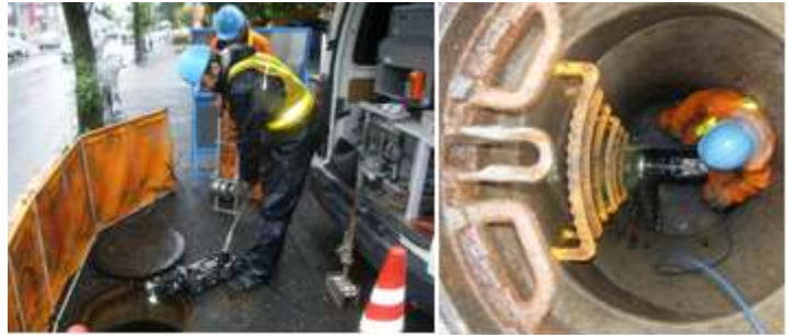
管きよ内調査の状況
