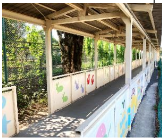
体育館渡り廊下
