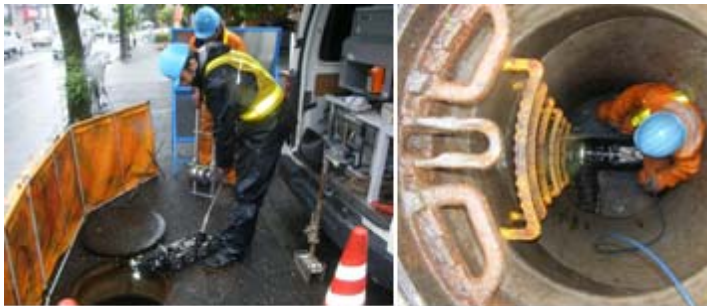
管きょ内調査の状況
