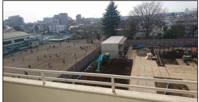
増築工事を行っている第五小学校
