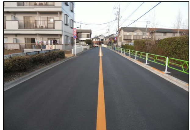
道路維持補修工事により整備された市道
