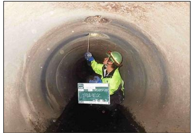
下水道管きよの調査の様子
