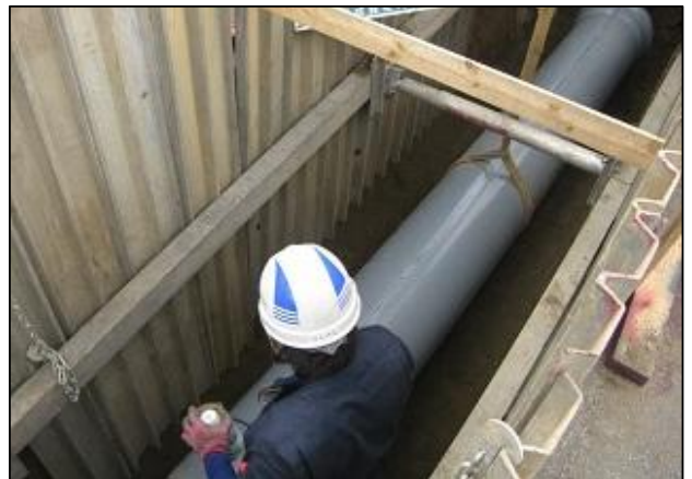
雨水管きよ築造工事の様子
