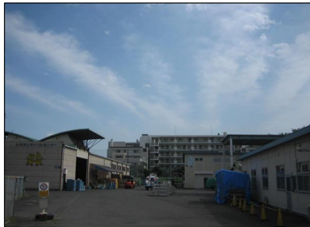
現在のリサイクルセンターの様子
