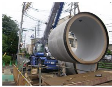
写真 雨水管きよ整備状況
