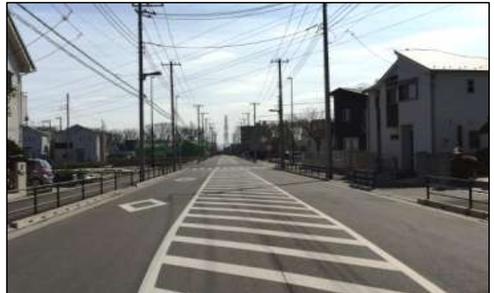
都市計画道路3・4・23号線の整備が完了した地域
