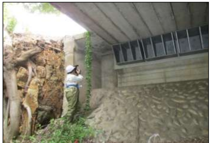
橋りょう点検の様子
