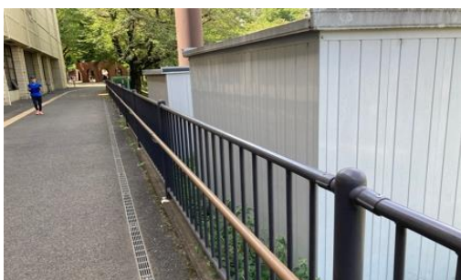
既存のフェンス
