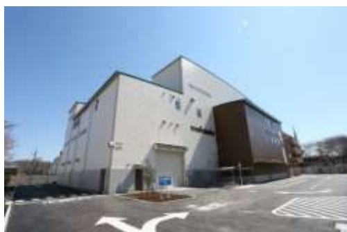
資源物中間処理施設の外観
