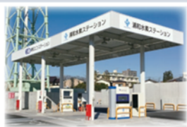
水素ステーション
